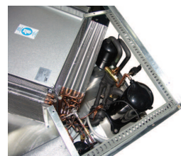
Охлаждающий контур со спиральными компрессорами с функцией теплового насоса
