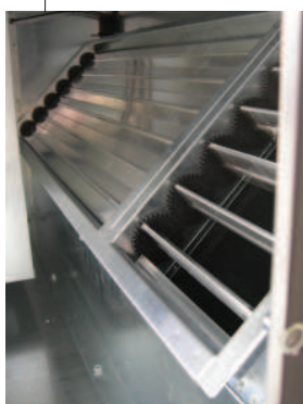
Модель Т предусматривает байпас для осуществления свободного охлаждения
